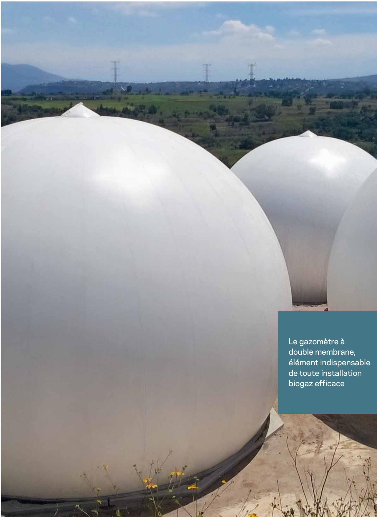
Le gazomètre à double membrane, élément indispensable de toute installation biogaz efficace
